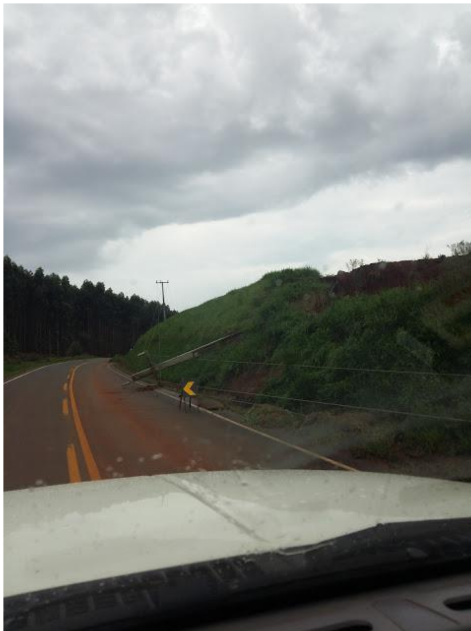
Figura 8: Foto de equipe de campo da Copel em local com desbarrancamento e queda de poste.
