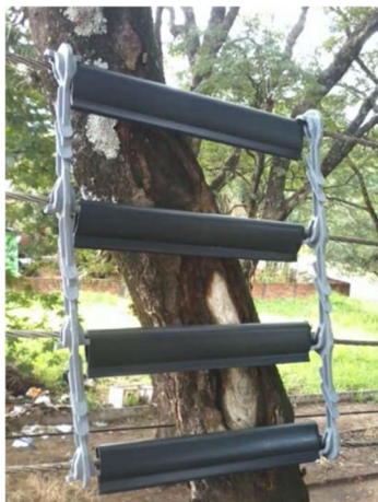
FIGURA 2 – MONTAGEM DAS COBERTURAS
