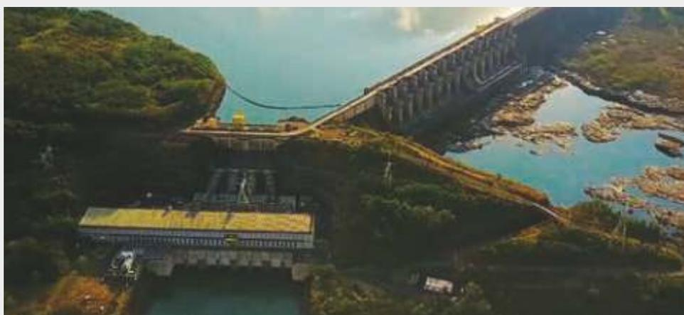
A casa de força é do tipo abrigada, e conta com quatro conjuntos de turbinas e geradores de energia, cada um com 310 megawatts (MW) de potência, somando 1240 MW de potência instalada na Usina. A energia produzida é suficiente para abastecer quase 40% da população do Paraná.
