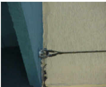
Exemplo de ancoragem com parafuso chumbado na parede e olhal reto
