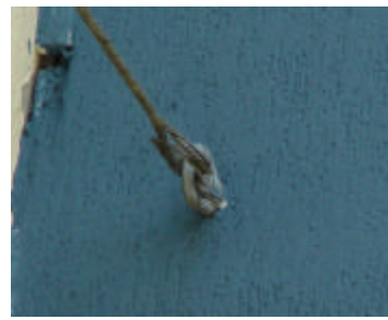
Exemplo de ancoragem com parafuso chumbado na parede e olhal reto
