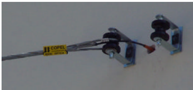
Exemplo de ancoragem com conjunto armação secundária de um estribo com isolador de porcelana
