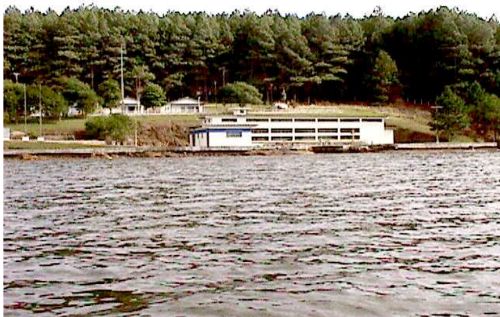
Captação de Água - Sanepar
