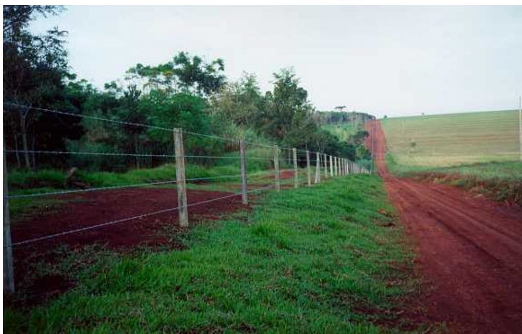
b) Restauração das cercas
