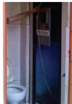
CLIENTE ABUSADO APROVEITA A CONSTRUÇÃO PROTETIVA DO MEDIDOR DE ALTA TENSÃO PARA ADICIONAR UM VASO SANITÁRIO E UM "GATO"
