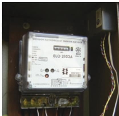
INSTALADO JUNTO A UM MEDIDOR DIGITAL, O TRANSMISSOR REPASSA, VIA RÁDIO, AS INFORMAÇÕES AO RECEPTOR PORTADO PELO LEITURISTA
