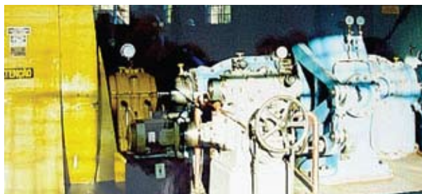
EM 1979, ANTES DA REFORMA
