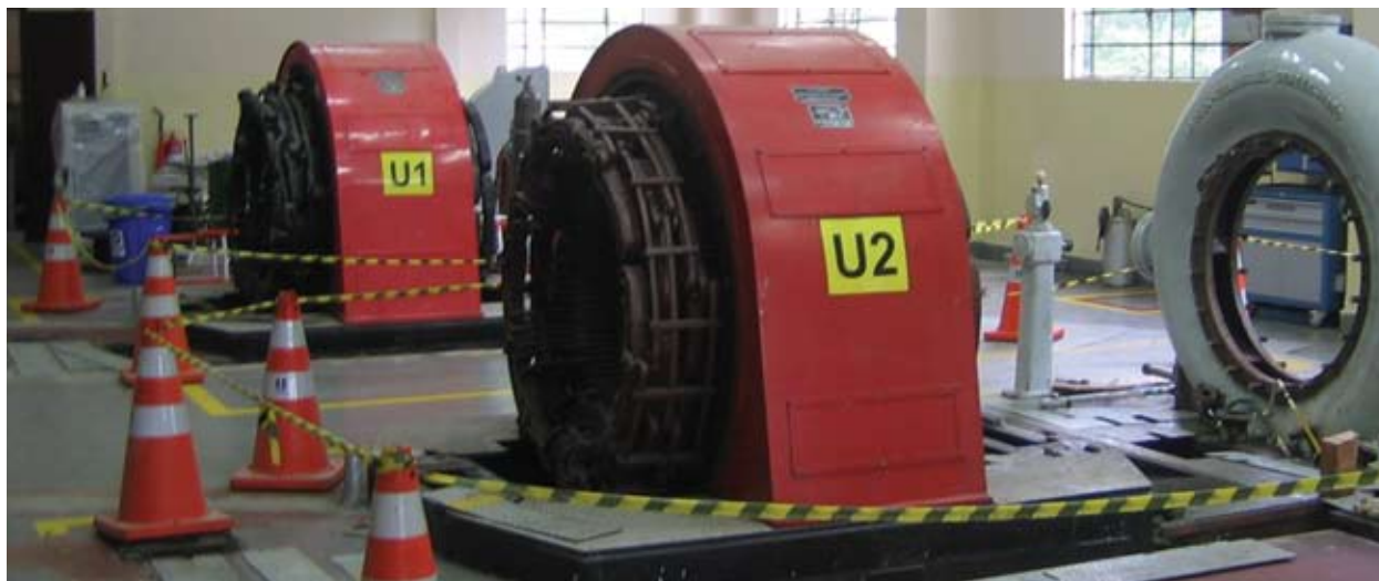
MONTAGEM DAS UNIDADES
