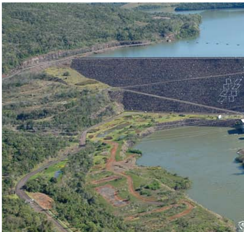
USINA SEGREDO NUM RARO MOMENTO, COM OS VERTEDOUROS ABERTOS.
