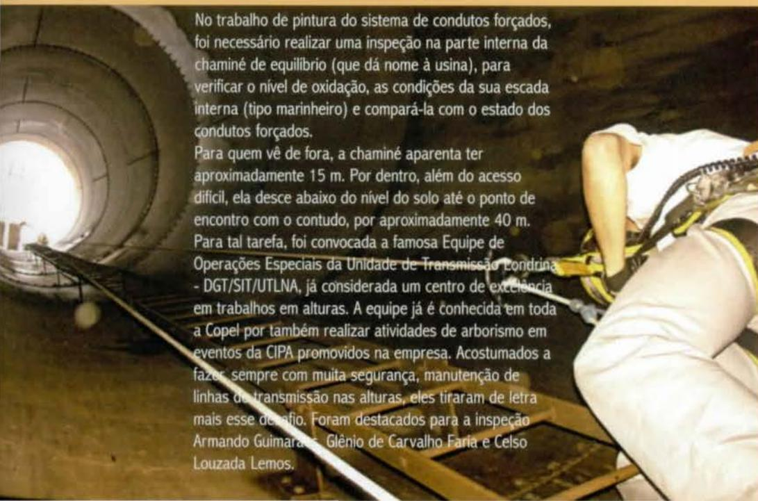
No trabalho de pintura do sistema de condutos forçados, foi necessário realizar uma inspeção na parte interna da chaminé de equilíbrio (que dá nome à usina), para verificar o nível de oxidação, as condições da sua escada interna (tipo marinheiro) e compará-la com o estado dos condutos forçados.
