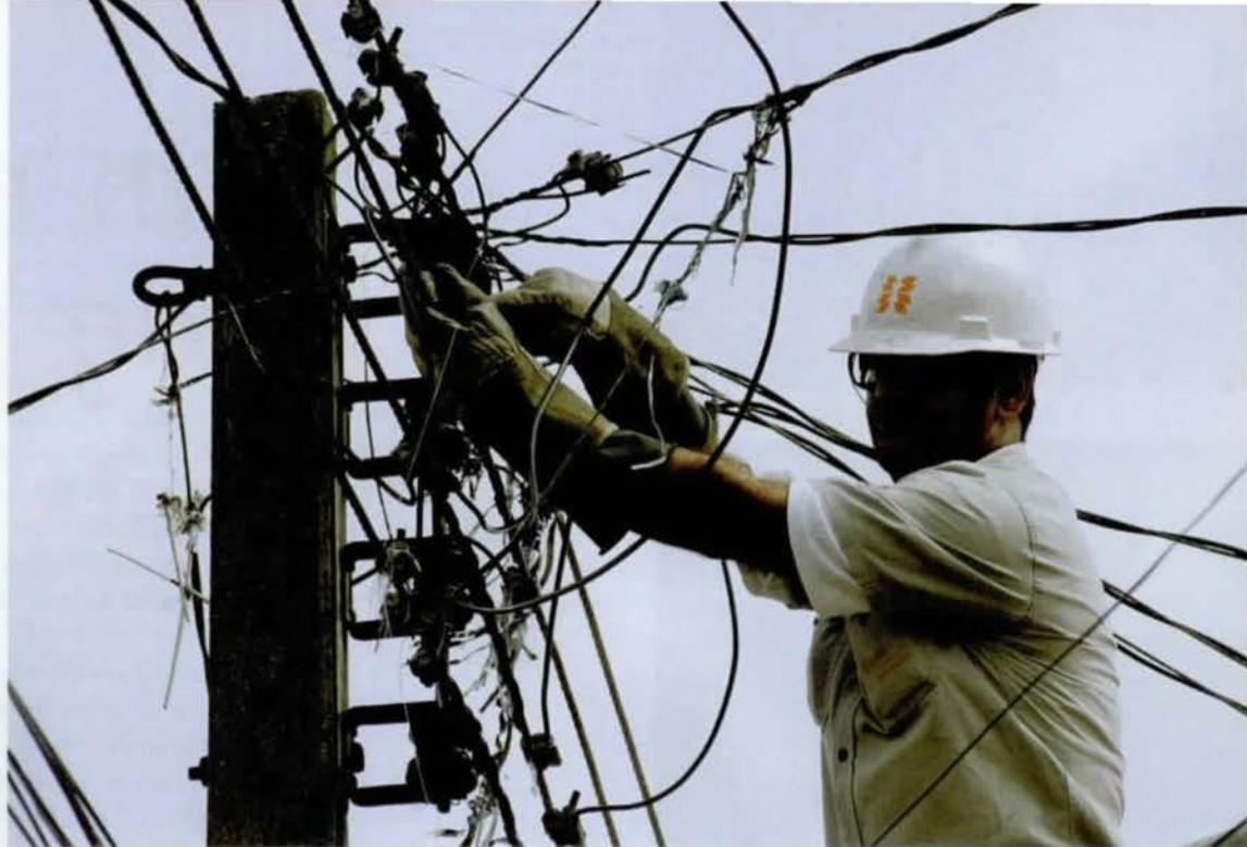
Ao mesmo tempo, equipes técnicas de manutenção percorreram todas as ruas inspecionando e fazendo a limpeza dos circuitos e redes de baixa tensão. Materiais e equipamentos avariados ou desgastados foram substituídos e transformadores sobrecarregados, trocados.
