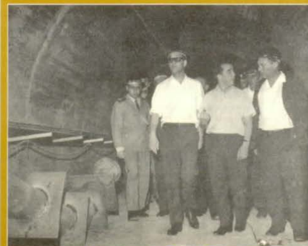
... e inspecionando as obras de Capivari-Cachoeira (1970)
