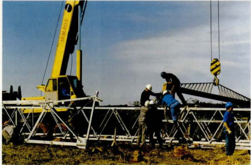
Copel Transmissão mobilizada no reparo das torres
