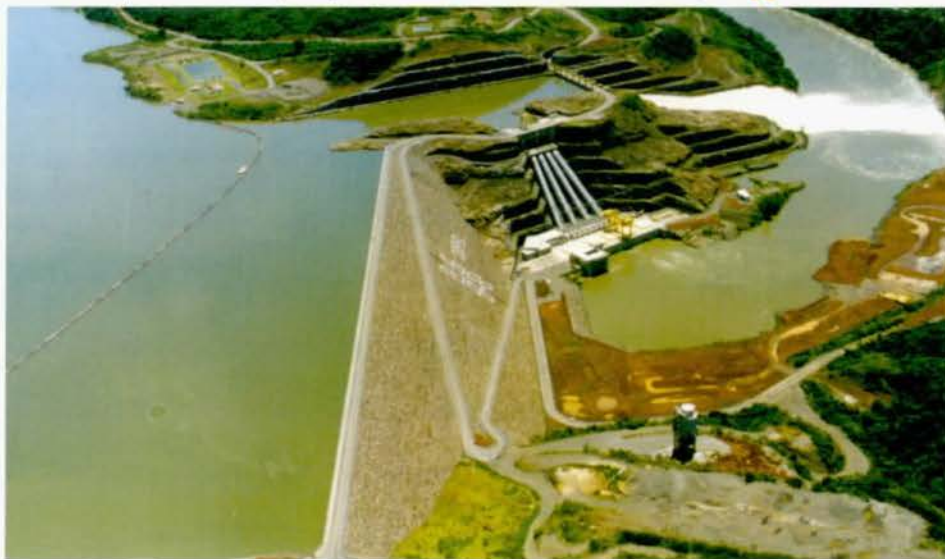
Consumo de energia cresce 11% na indústria e hidreletricas geram mais
