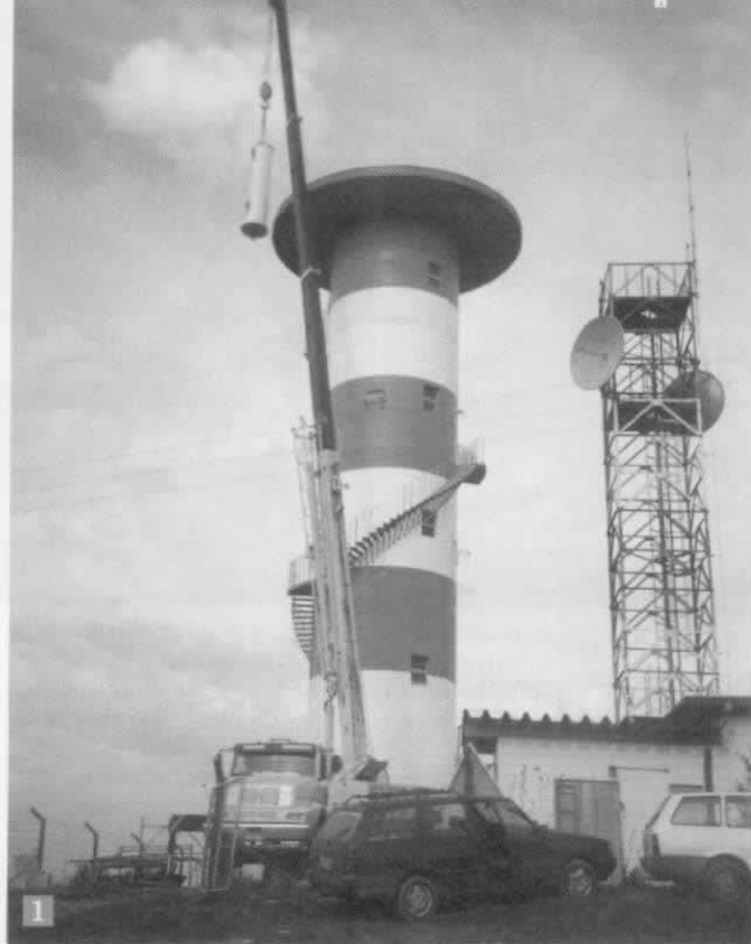
A montagem do radar começou com a construção de uma torre de 25 metros em Irati.
