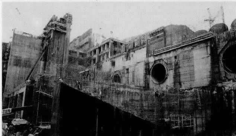
Os condutos forçados fazem parte dos 55% das obras civis da usina já concluídos
