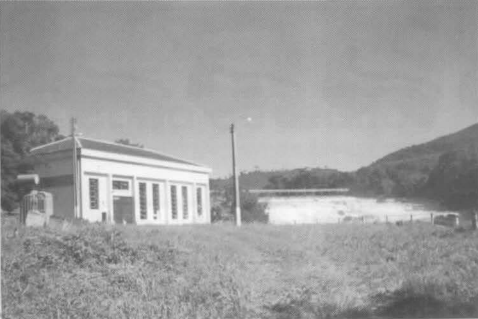
A usina de Cavemoso entrou em operação em 1965. É automatizada, com potência de 1,2 MW.
