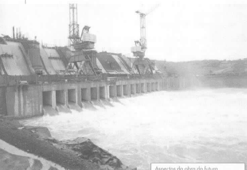
Aspectos da obra da futura hidrelétrica de Salto Caxias.
