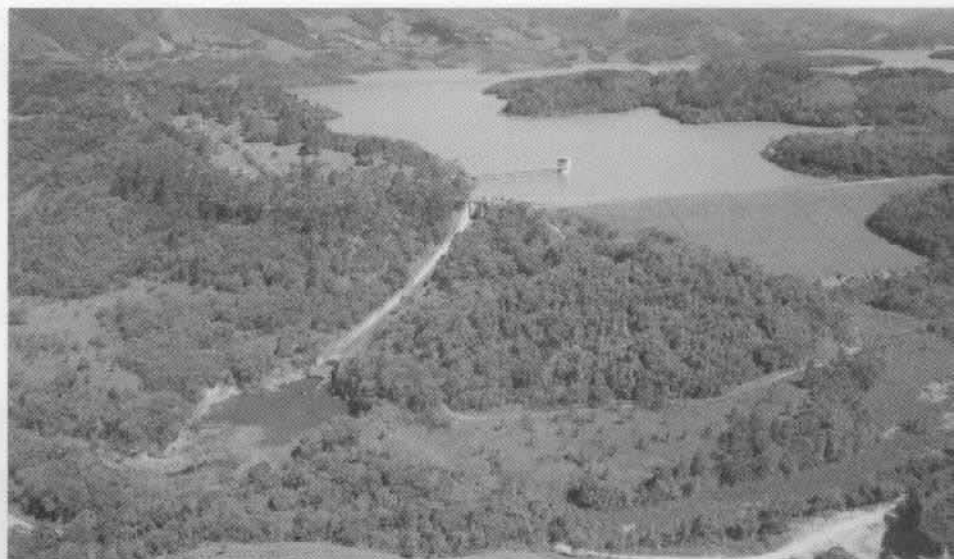
Vista aérea da Usina Gov. Parigot de Souza (a montante)
