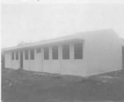
Posto de saúde construído em Capitão Leônidas Marques (distrito de Alto Alegre do Iguçu)
