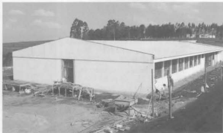
Escola construída pela Copel em Boa Vista da Aparecida
