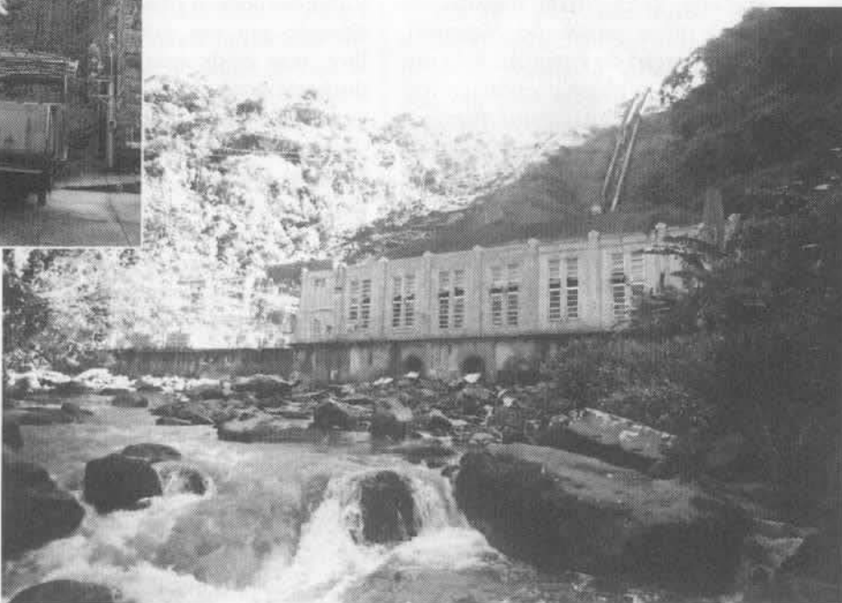
O trólei desce 600 metros até a casa de força da Usina de Chaminé
