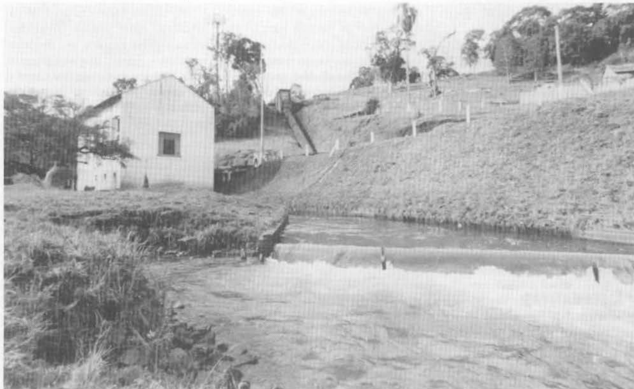
Salto do Vau é a primeira PCH automatizada
