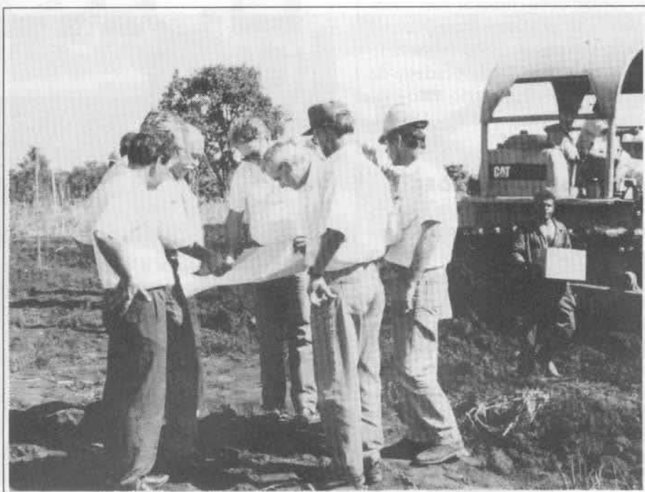
O trator faz a terraplenagem e os técnicos examinam as plantas
