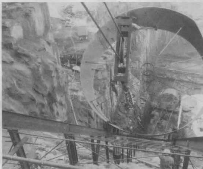
Instalação das vólvulos do conduto 4: operação difícil mas fundamental para o cronograma de construção da casa de força e da tomada d'água.
