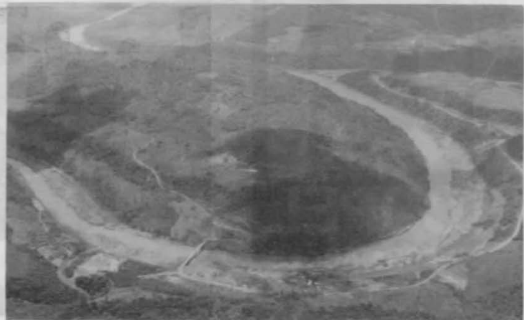
O Rio Iguçu em seu curso original nos primórdios da construção de Segredo; as obras preliminares para o desvio foram iniciadas em novembro de 1986.
