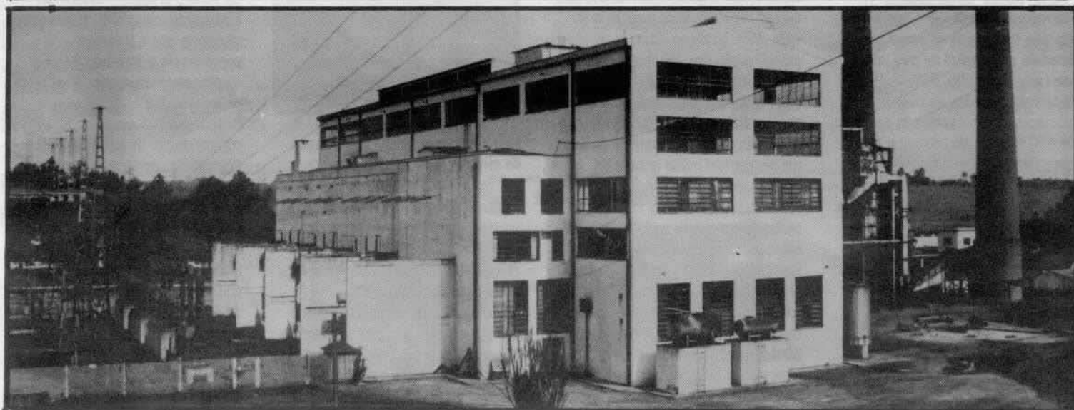
A Usina Termelétrica de Figueira foi inaugurada em 4 de abril de 1963 – completou 27 anos de operação – e incorporada à Copel em 1969. Tem uma potência instalada de 20 MW e está localizada no município do mesmo nome.
