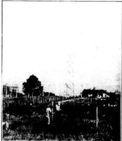
A construção das cercas
