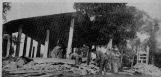
Trabalho duro para a construção do módulo.
