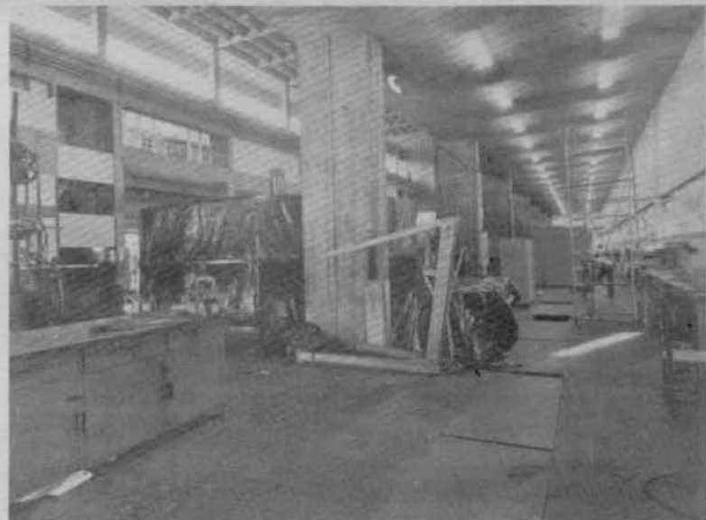
Retirada das máquinas para a recuperação.
