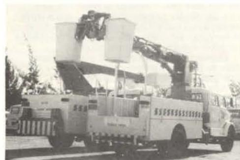
incorporada aos mecanismos e também uma garra), tracionamento de materiais e equipamentos (é equipado com guincho que suporta levantar até 5 mil kgf/metro) e ainda lança retrátil, que pode elevar-se até uma altura máxima de 14,5 metros. Já o "Pélican" dispõe apenas da lança, que pode projetar-se até uma altura máxima de 12 metros. As carrocerias desses veículos são projeto e criação da Copel, que além de supervisionar a construção, determinou especificações quanto a cabine e reforço dos chassis.
