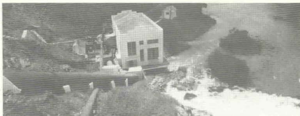
No entrelaçamento dos condutos forçados, a marca das seguidas ampliações.
