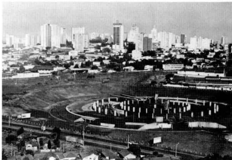
Nova rodoviária em construção.
