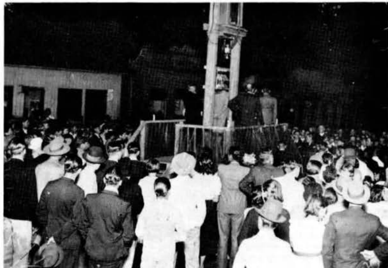
Implantação da energia elétrica – 11.6.1938.
