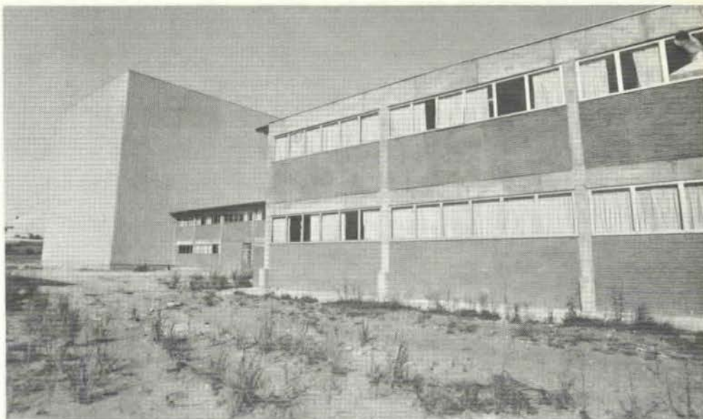
Aspecto geral das instalações do Laboratório. À esquerda, a "Gaiola de Faraday", compartimento à prova de interferências eletromagnéticas para permitir condições ideais de precisão em ensaios de Alta Tensão.
