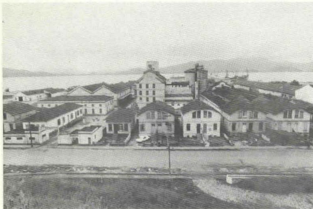
O Moinho Matarazzo, situado ao lado do terminal de carvão, foi responsável durante muitos anos pela movimentação do porto e pela própria vida econômica de Antonina. Hoje está fechado, e suas instalações, abandonadas.
