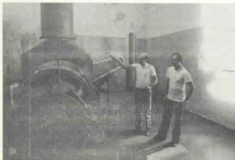
Arnaldo e Zezinho, banho de champanhe ao gerador.
