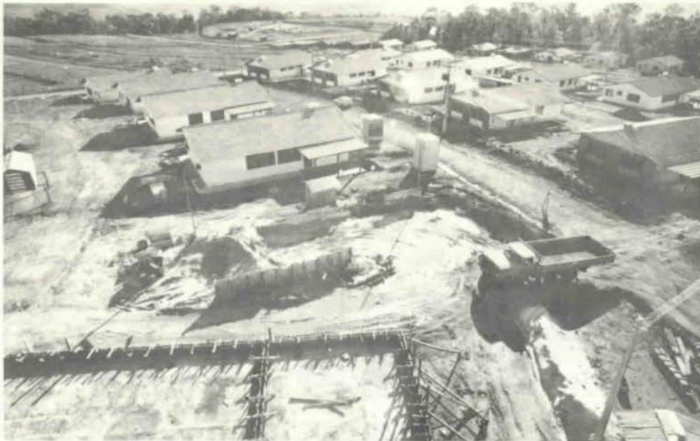
400 casas em construção na Vila
