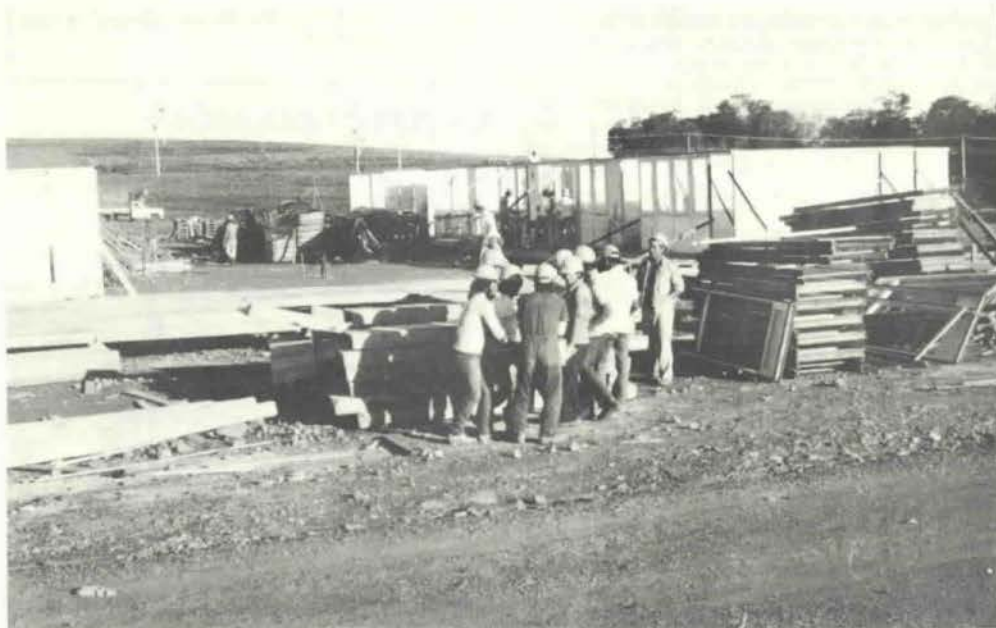
Obras do alojamento principal
