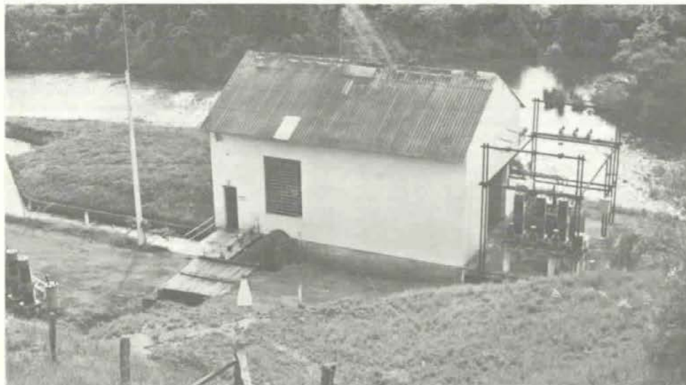
A usina e a subestação vistas do castelo (tomada d'água).
