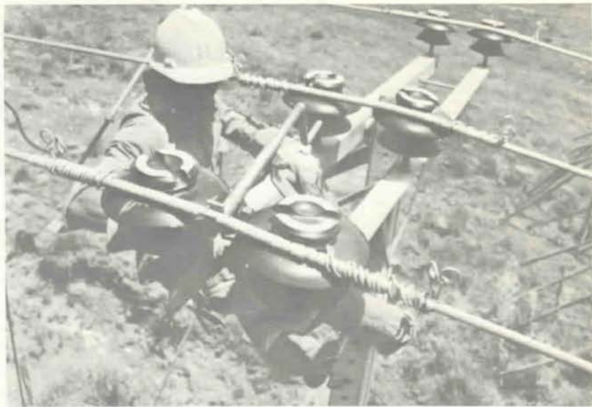
Equipamento instalado, pronto para a operação.
