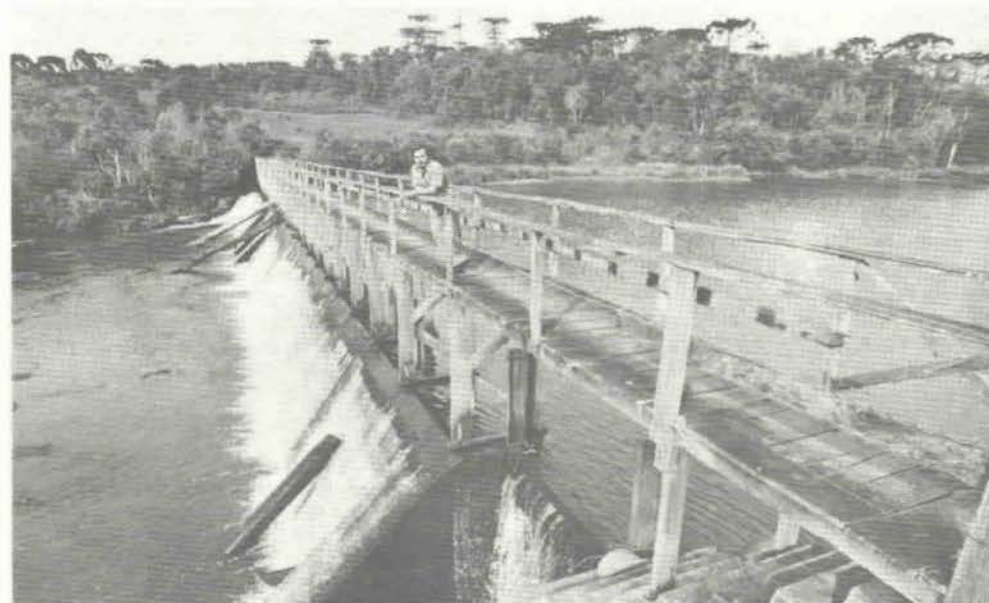
Barragem da usina.
