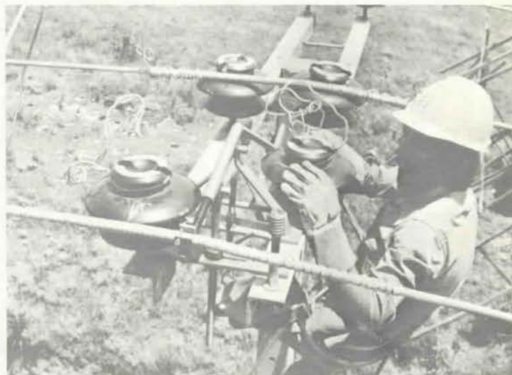
Isolador sendo substituído.
