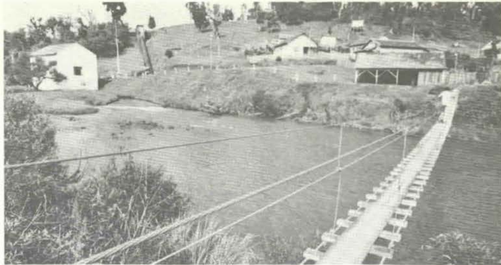
A ponte pênsil que dá acesso à usina.
