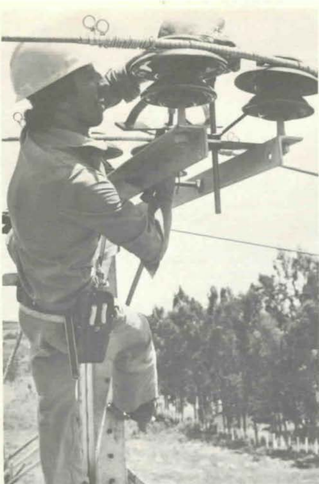
Eletricista instalando o baitaca.
