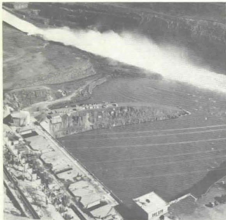
A Casa de Força, do tipo semi-abrigado. Logo atrás das escotilhas que permitem o acesso vertical aos geradores, situa-se a Subestação SF6.
