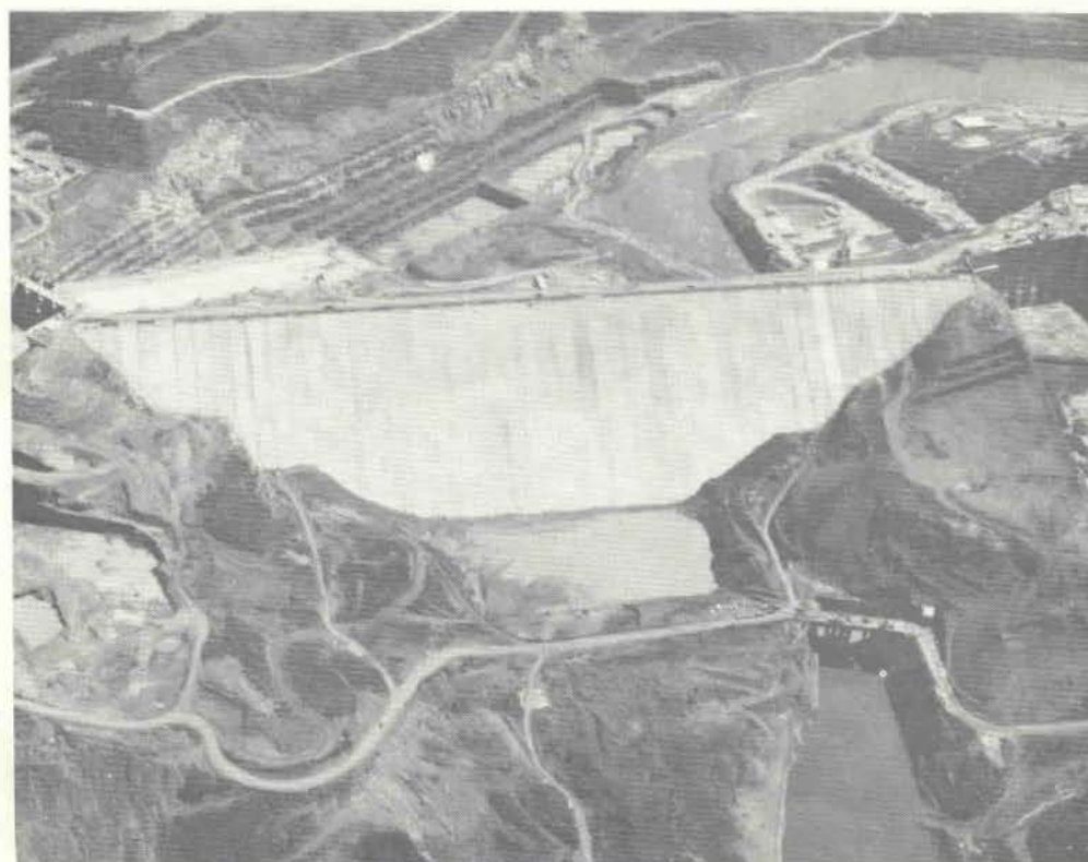
A grande barragem, quando teve concluída a concretagem na sua face à montante, hoje coberta pelas águas.
