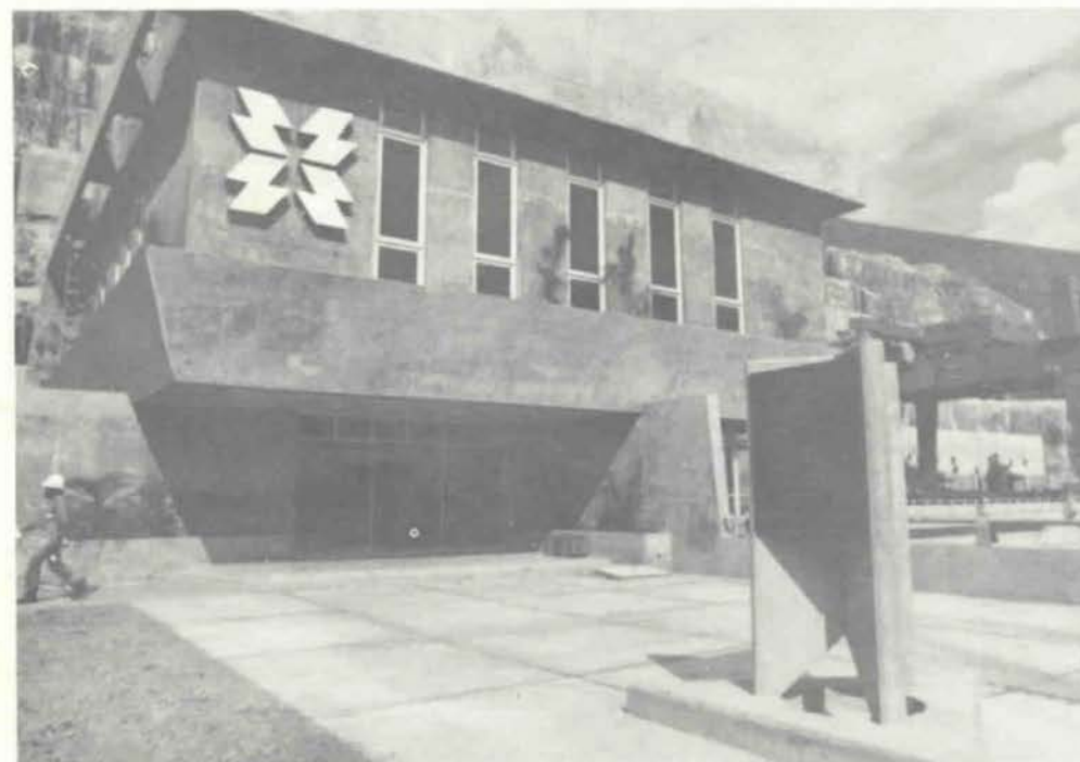
O marco encontra-se próximo à Casa de Comando da Usina. Na outra página, detalhe da placa comemorativa.
