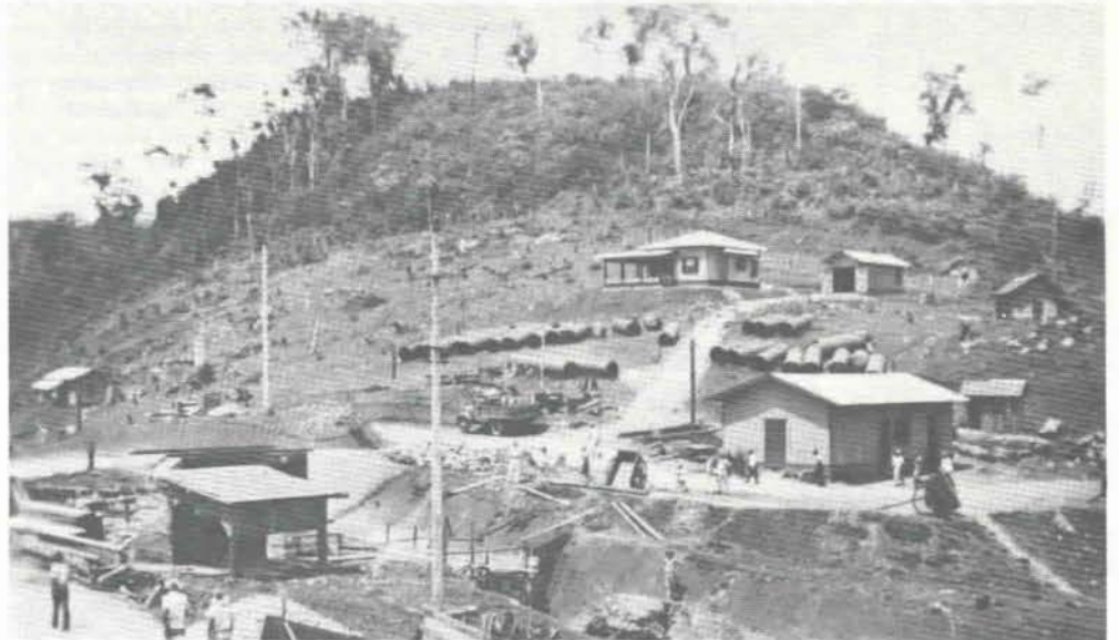
Apucarantina, 1946. Início da construção.
