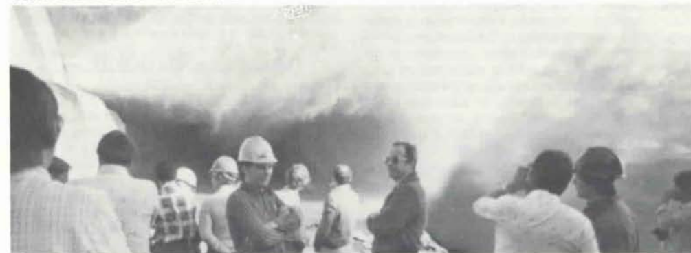
Douglas Souza Luz e Lindolfo Zimmer, Presidente e Diretor de Engenharia e Construções, respectivamente, acompanharam a abertura das comportas do vertedouro da Usina Foz do Areia.
