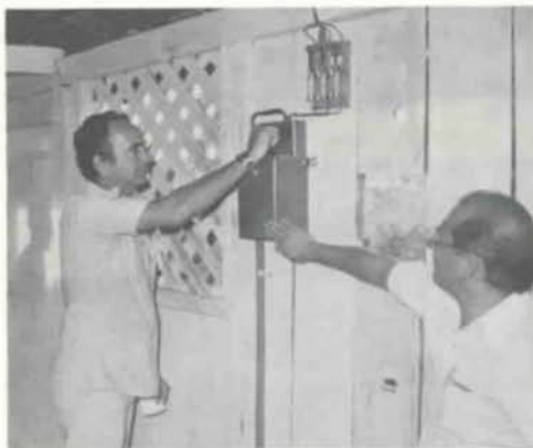
Ao acionar uma chave o Presidente da COPEL colocou em funcionamento inúmeros equipamentos elétricos de uma fazenda. Inaugurou-se assim mais uma obra de eletrificação rural no interior do Estado.
