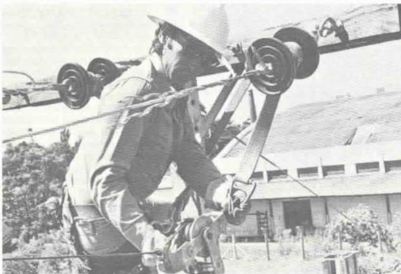
Ludovico faz demonstração do tensionamento de um cabo condutor, utilizando-se da correia ou "estropo". Nesse caso o trabalho é mais difícil.
