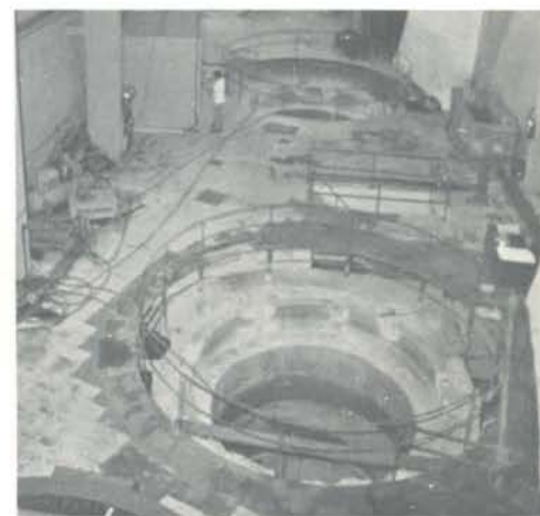
A casa de força já sem as unidades I e II.
