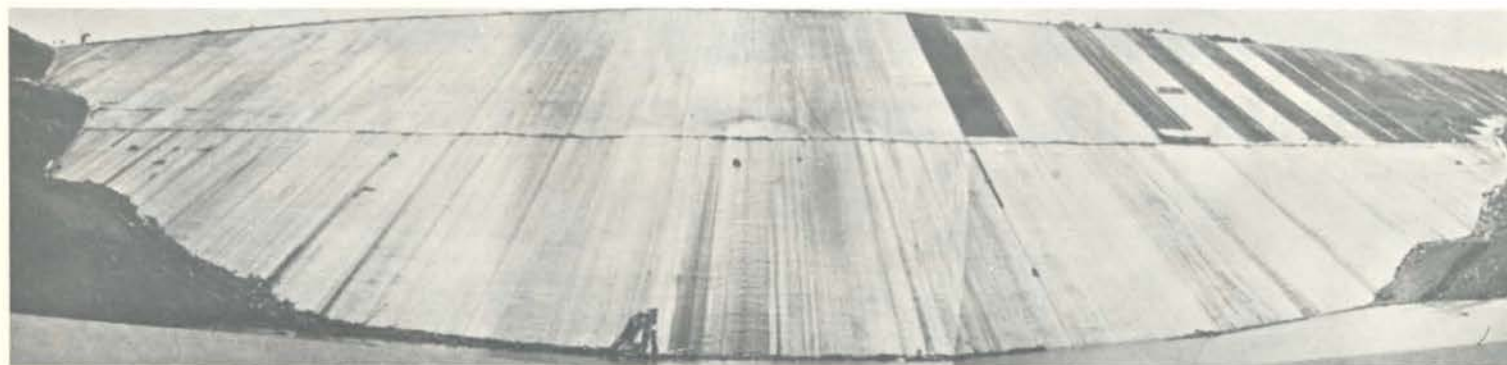
Vista à montante da barragem de Foz do Areia, com seu capeamento de concreto quase concluído.
