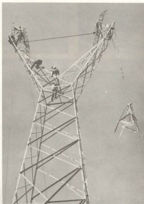
Construção da linha de transmissão Ponta Grossa—Curitiba.
