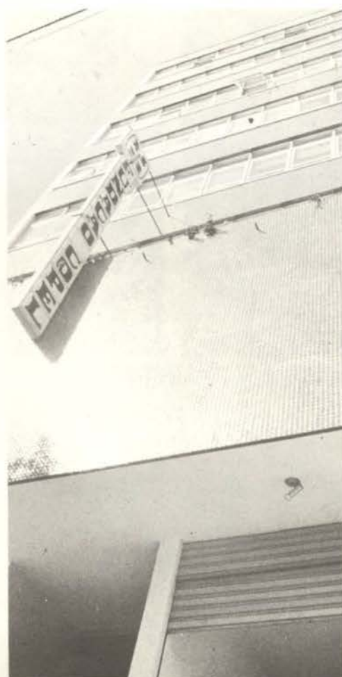
Edifício à rua Carlos de Carvalho 787, em Curitiba, abriga a administração central.
