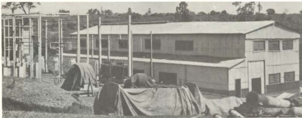
Maringá, em 1954, recebeu do Departamento de Águas e Energia Elétrica (D.A.E.E.) esta usina dieselétrica com quatro motores. Funcionava das 7 às 11h30m e das 18 às 22 horas.
