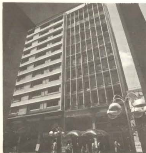
Outro edifício que abrigou as primeiras instalações da COPEL (R. XV de Novembro).
