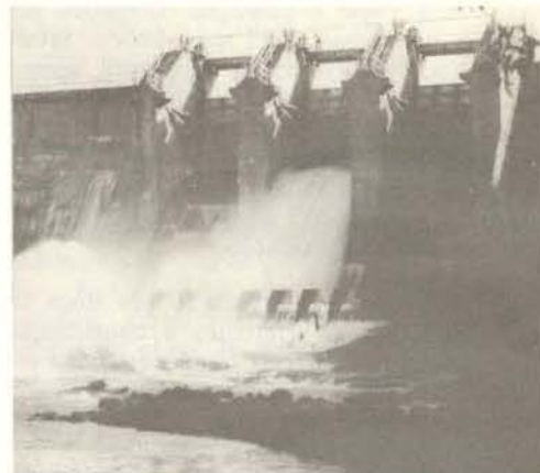
Usina Hidrelétrica de Chaminé.
