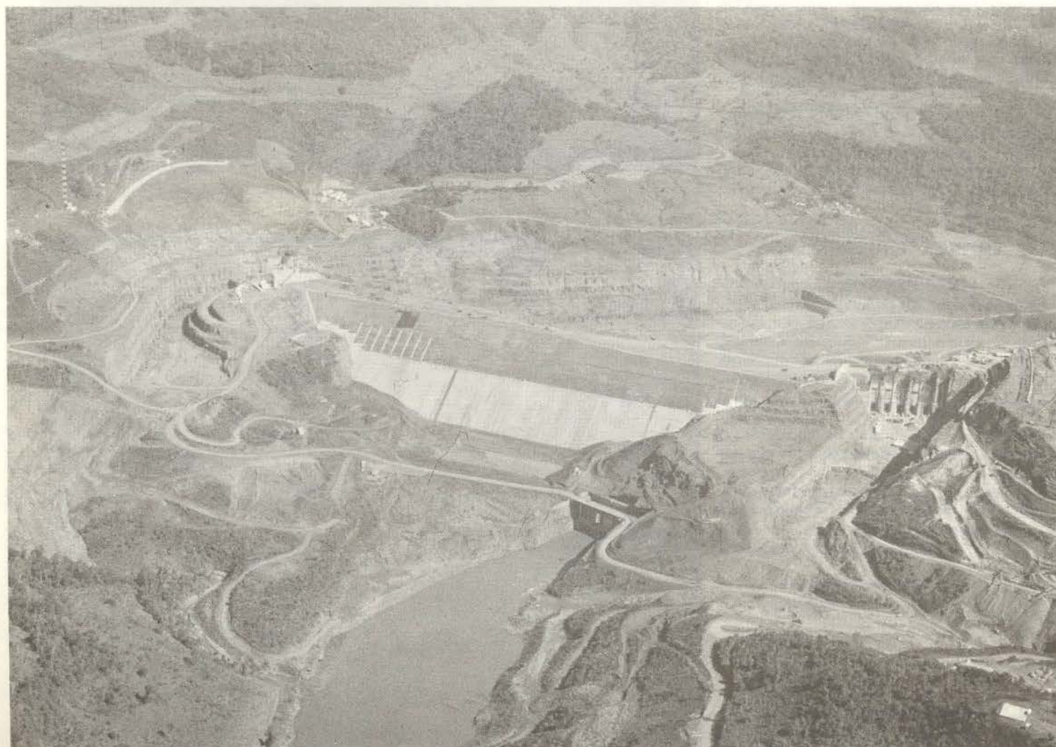
A barragem já atingiu a sua altura máxima: 160 m. É, hoje, a maior estrutura do mundo, em seu tipo.
