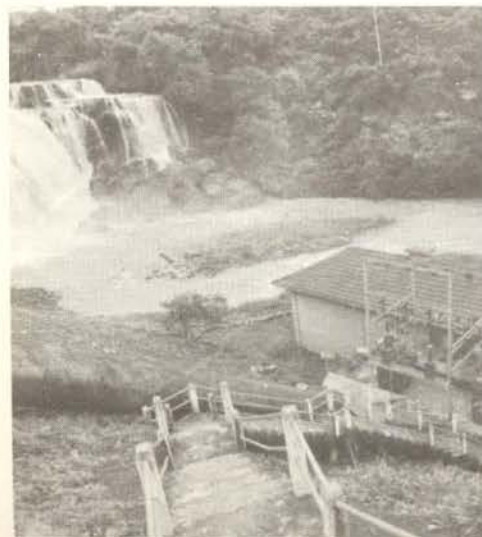
Usina Hidrelétrica de Melissa.
