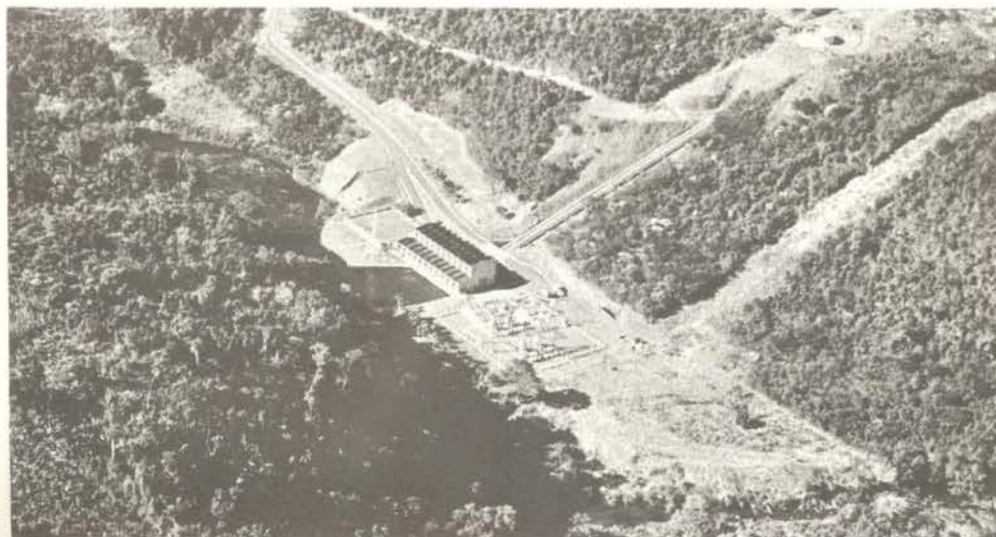
Usina Hidrelétrica Mourão I.
