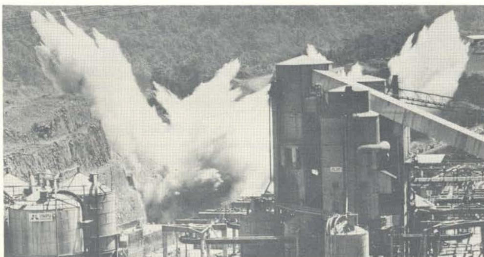
Eliminadas as barragens por ação de 55 toneladas de explosivo, o Paraná ganha novo curso, para permitir o andamento dos trabalhos sobre o antigo leito do rio. Em 1983, consoante seu cronograma de obras, a grande hidrelétrica iniciará sua geração de força.
