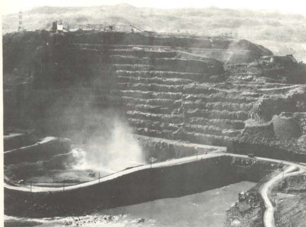
Ao lado do canal de descarga dos túneis de desvio, e protegida por muro de rocha, a área onde se localiza a casa de força e o canal de fuga.
