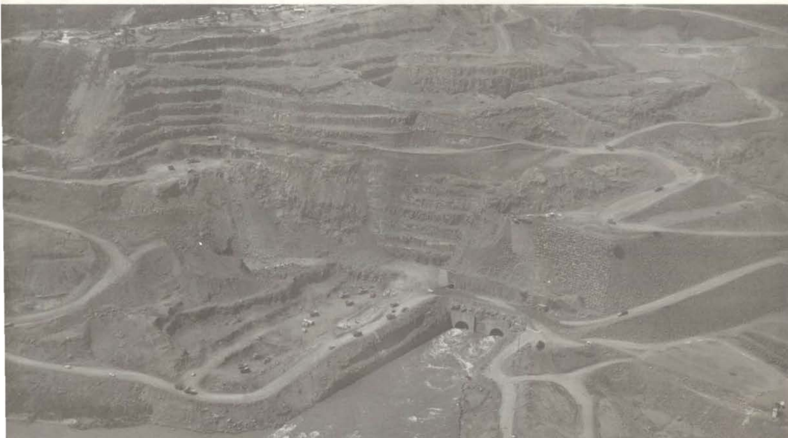
À esquerda das bocas dos túneis de desvio, as escavações na área da casa de força e do canal de fuga; mais acima delas, notam-se as escavações do canal de adução.
