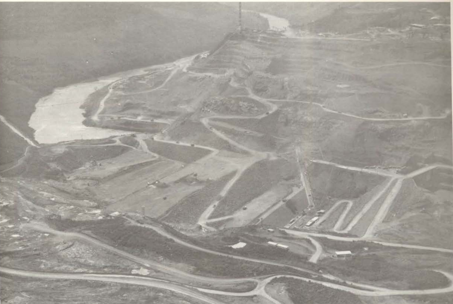
Da margem esquerda do Iguazu pode-se melhor apreciar o considerável avanço das obras de assentamento da barragem, lançada sobre o antigo leito do rio.
