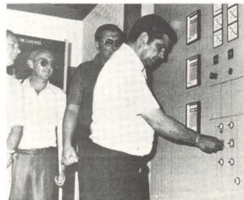
O Governador Jayme Canet Júnior acionou o dispositivo que colocou em operação a Subestação Cascavel II.
