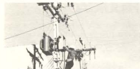
Os alunos de Medição Comercial de Distribuição, têm oportunidade para executarem um trabalho de campo, nas estruturas e equipamentos preparados especialmente para isso, no pátio do DPTF.
