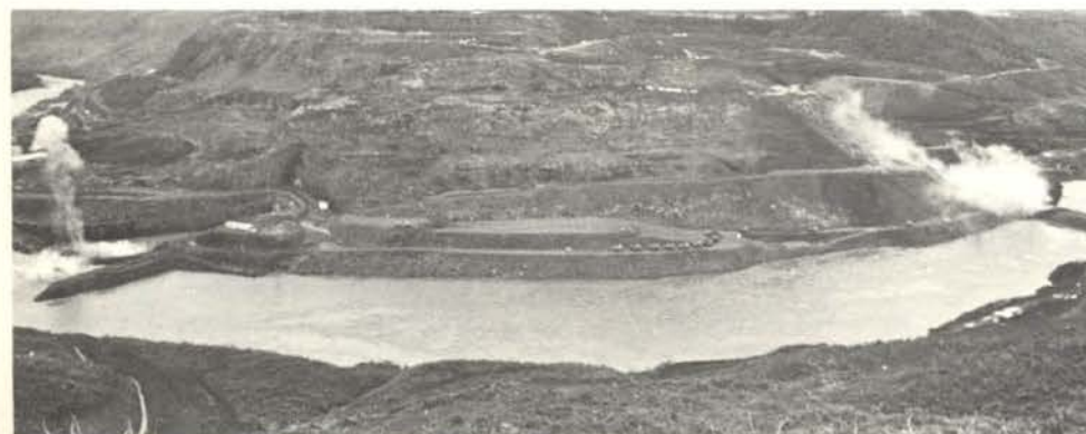
A segunda explosão, no dique de jusante.
