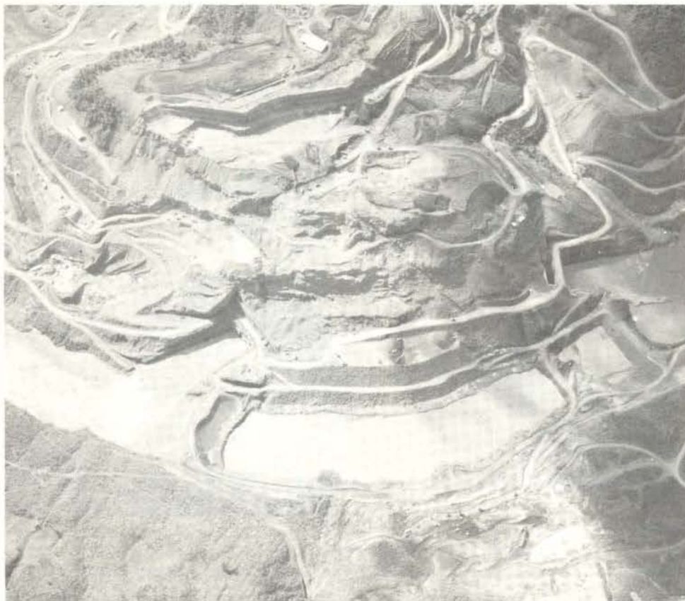
Vista geral da obra principal, 30 dias após o desvio.
