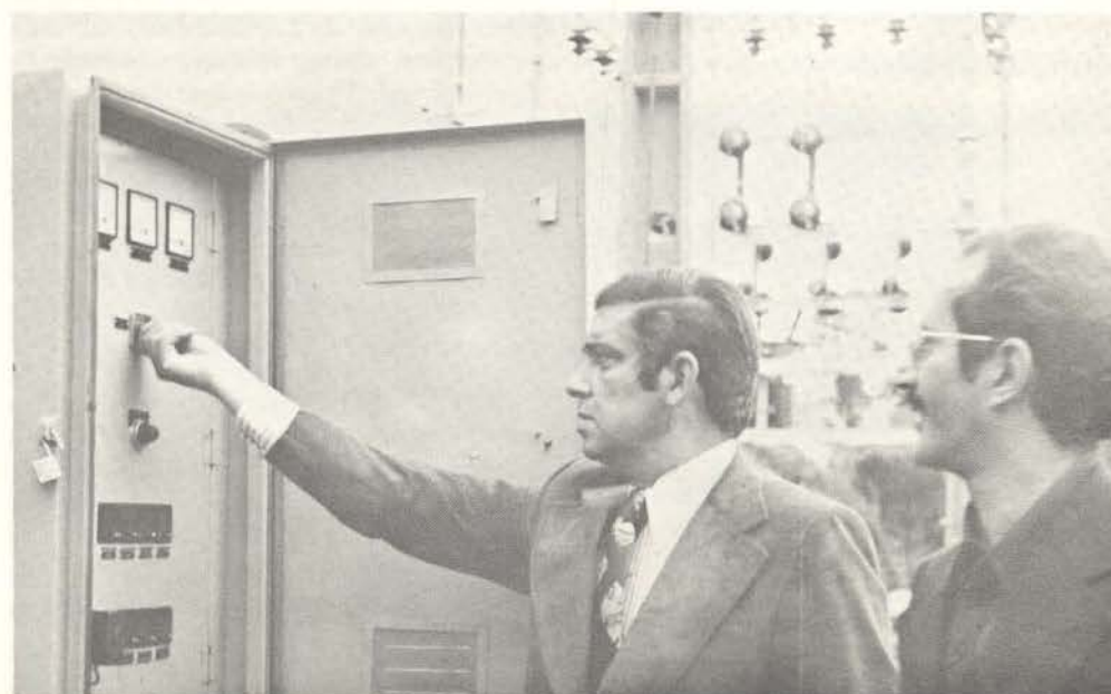
O Governador Canet Junior, tendo ao lado o Diretor Econômico Financeiro da COPEL, Edson Neves Guimarães, quando acionava a chave, dando por inaugurada a Subestação Aeroporto em Foz do Iguaçu.
