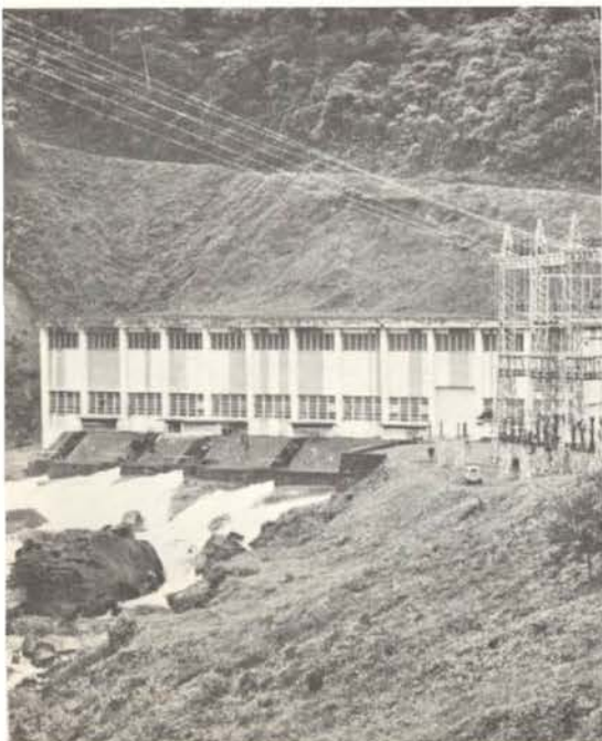
Usina de Guaricana.
