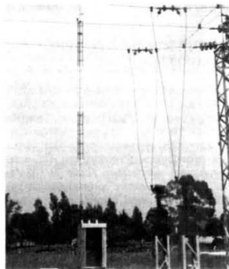
Cabículo e torre VHF.
