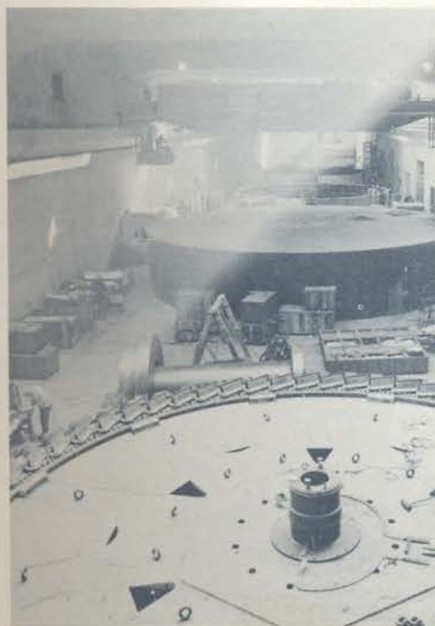
Geradores em montagem.
