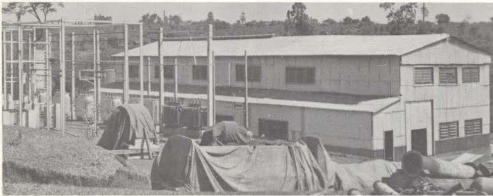
Maringá, em 1954, recebeu do Departamento de Águas e Energia Elétrica (DAEE) esta usina dieselétrica com quatro motores. Funcionava das 7 às 11h30min e das 18 às 22 horas.
