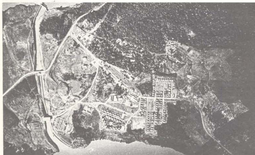
A usina de "Júlio de Mesquita Filho" entrou em operação no dia 29 de janeiro de 1970 e tem 44 mil quilowatts de potência.
