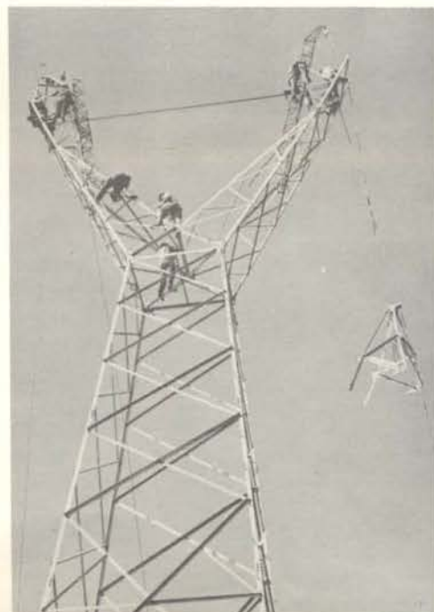
Construção da linha de transmissão Ponta Grossa—Curitiba.
