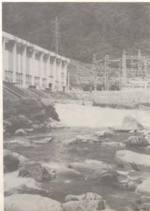
Usina Hidrelétrica de Guaricana.
