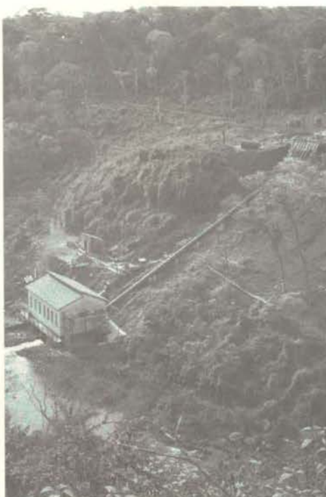
Usina Hidrelétrica de Ocof.
